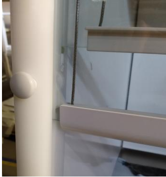
Kuva 5. Nostorajoittimen sijainti vetokaapin reunassa.
